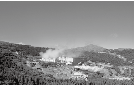
九重の雄大な自然の中にある八丁原発電所
